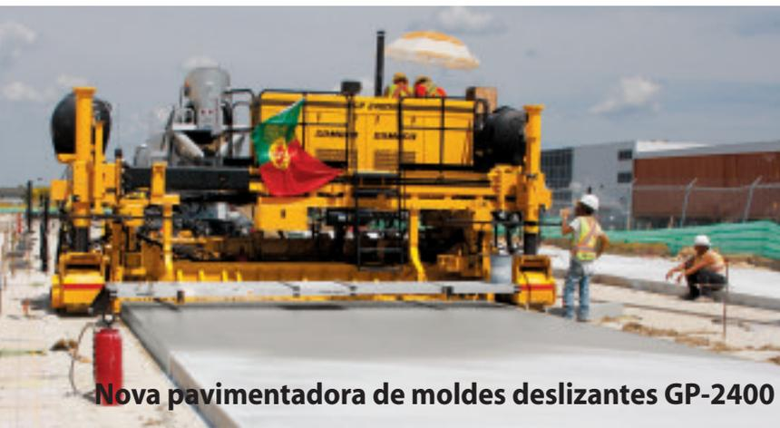
**Nova pavimentadora de moldes deslizantes GP-2400**
